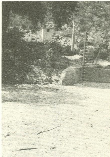
Escala, limnígrafo y estructura de aforos localizados en la margen derecha.
